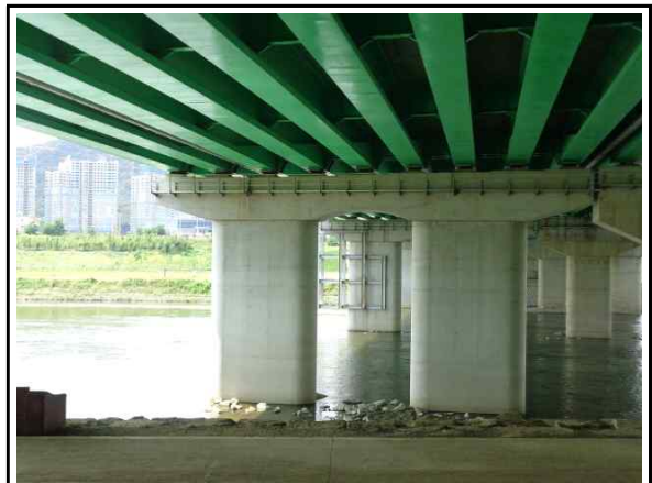
교각 P4 점검로 현황
