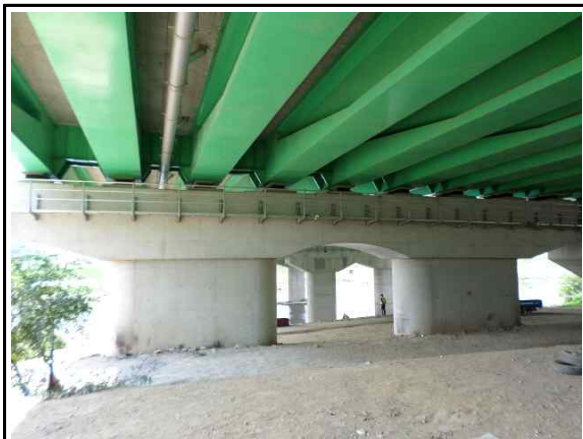
교각 P2 점검로 현황
